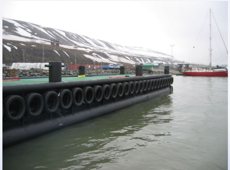
NOFI SPITSBERGEN, 5 x 21 meter på plass hos kunde. Denne har en høyde over vann på 1,5 meter.
